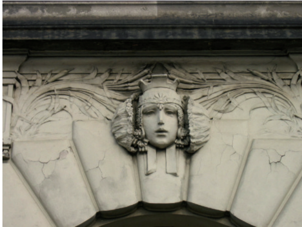
Abb. 9, Schlussstein, Bahnhof Prag
