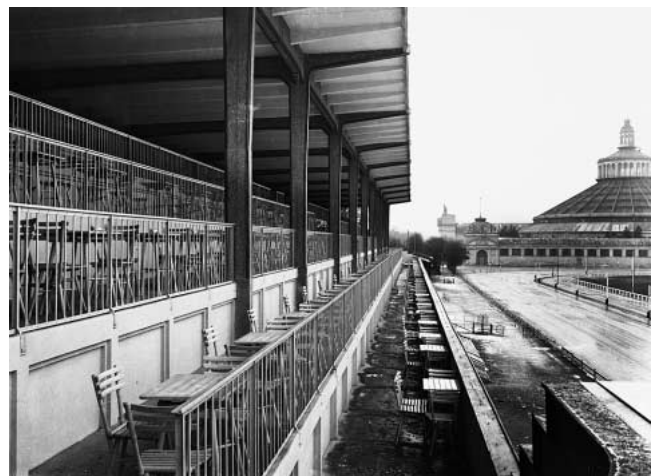
Trabrennplatz Krieau von Emil Hoppe, Marcel Kammerer und Otto Schönthal, Restaurant in der II. Etage, (1911–1913, 1918). © ÖNB
