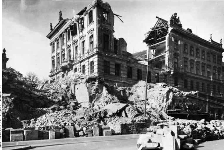
Die durch den Bombentreffer am 12. 3. 1945 schwer beschädigte Albertina. Ein Teil der alten Rampe noch erkennbar.
