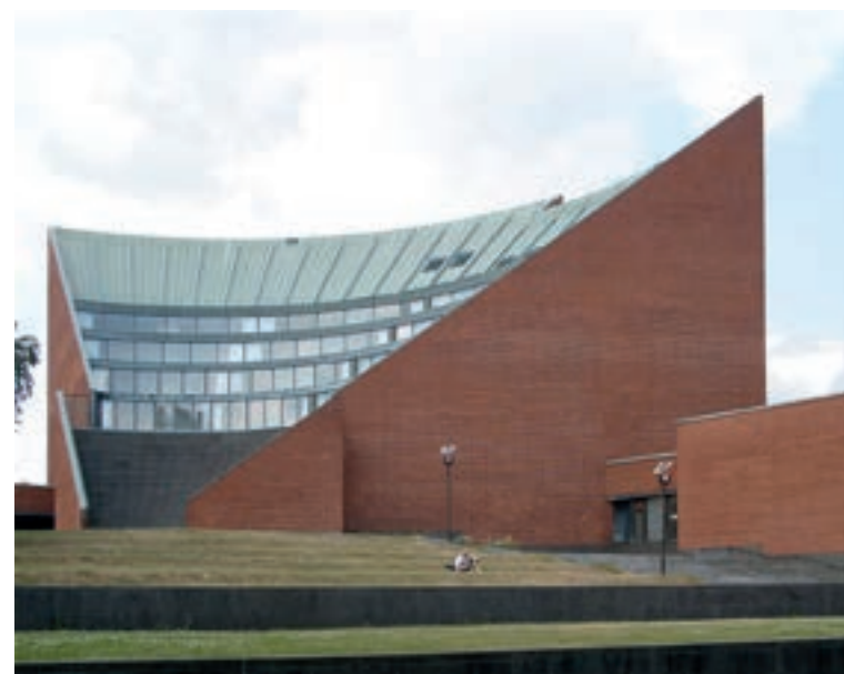
Abb. 3: Aalto University Espoo, Hauptgebäude.
